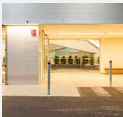
Gran Vía: reformas de todos los accesos del parking.
