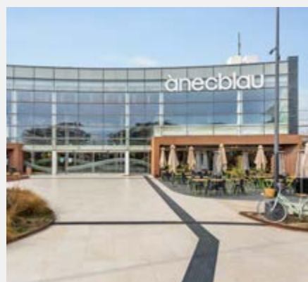
Ànec Blau: finalización de la fachada y nueva zona de restauración exterior.
